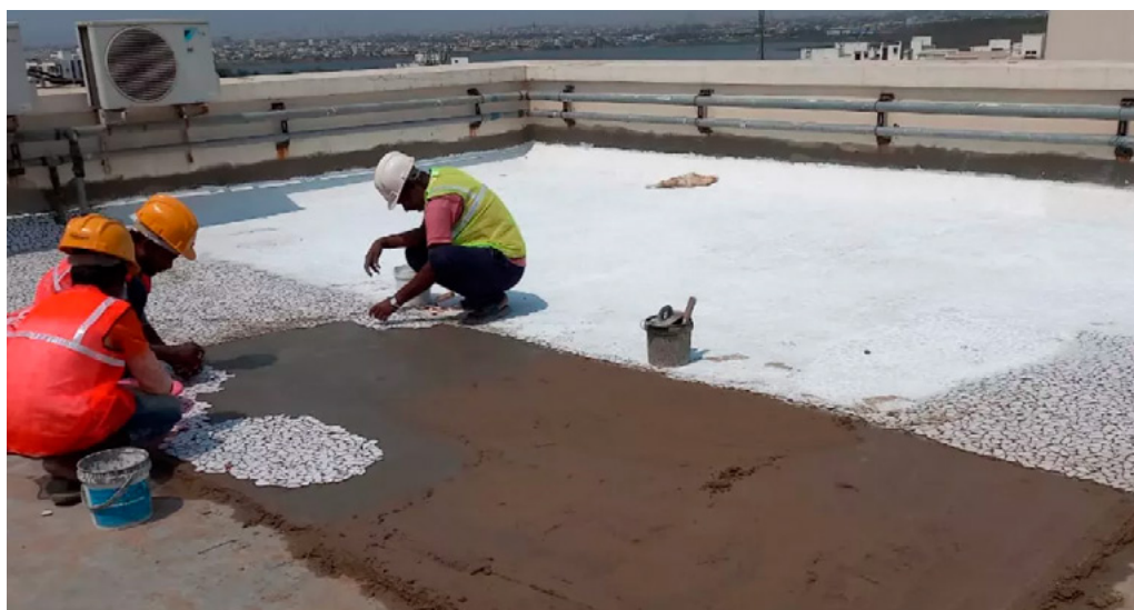
Instalação de telhados frios na Índia.
