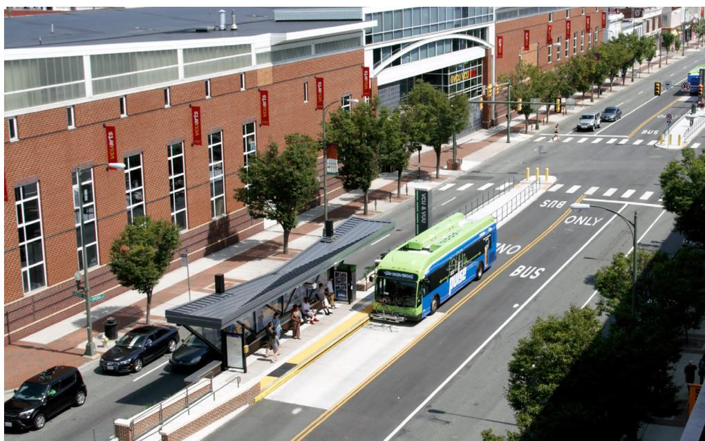
A estação do sistema PULSE em Richmond, VA, EUA, fica a uma distância de um ônibus da interseção, permitindo que outro ônibus pare atrás do que está na estação, se necessário. CRÉDITO: ITDP
