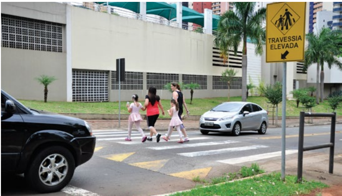
Figura 42 – Travessia elevada, Londrina/PR.
