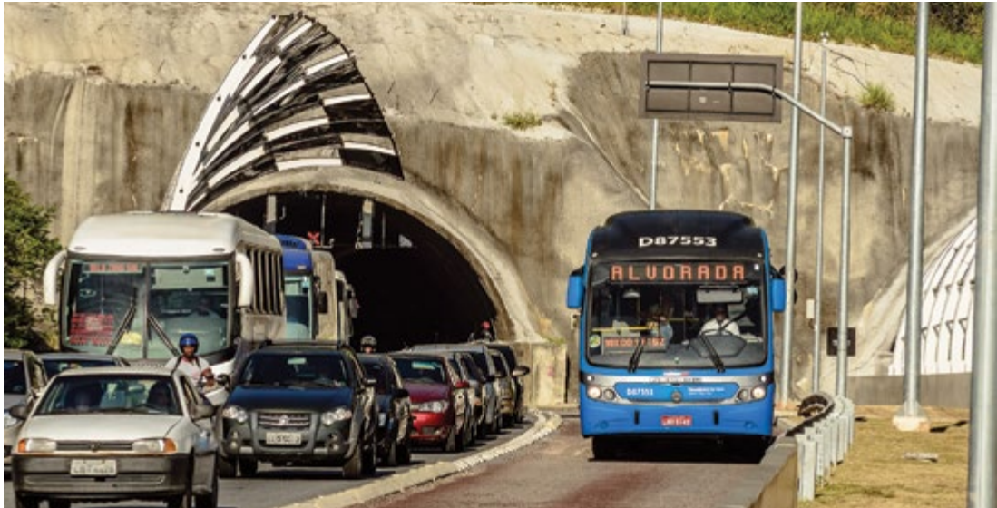
Figura 46 – BRT TransOeste, no Rio de Janeiro/RJ.
