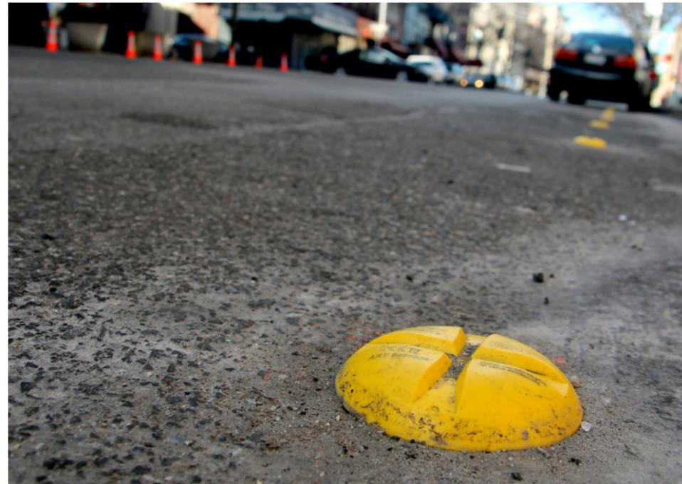
Sensores instalados nas pistas podem detectar se uma vaga está disponível e transmitir a informação aos motoristas em tempo real, o que reduz o tempo perdido em busca de vagas.
