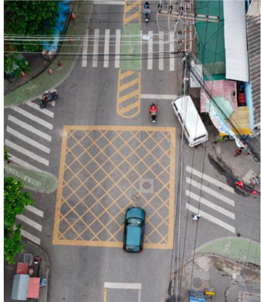
**Figuras 33 e 34.** Rua Capitão Teixeira com a avenida do Canal (próximo ao CIEP Frei Veloso): redução do raio de curvatura, faixa de travessia de pedestres, ilhas de proteção para o pedestre, definição de área de retenção para conversão que dá acesso à Avenida Pedro da Cunha e demarcação da área de cruzamento.
