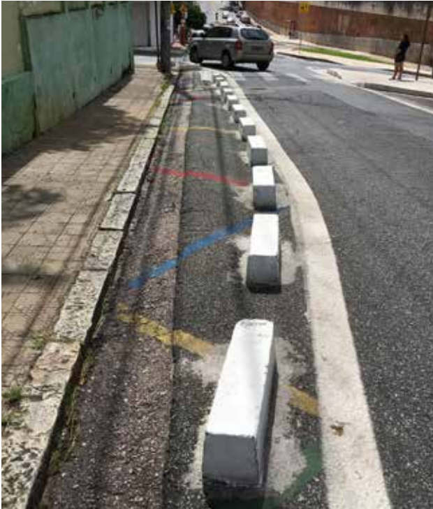
À esquerda: balizadores de concreto foram utilizados para manter a nova configuração da via após o término da ação temporária. À direita: Alargamento de calçada e cobertura para o ponto de ônibus. Imagens: BHTrans
