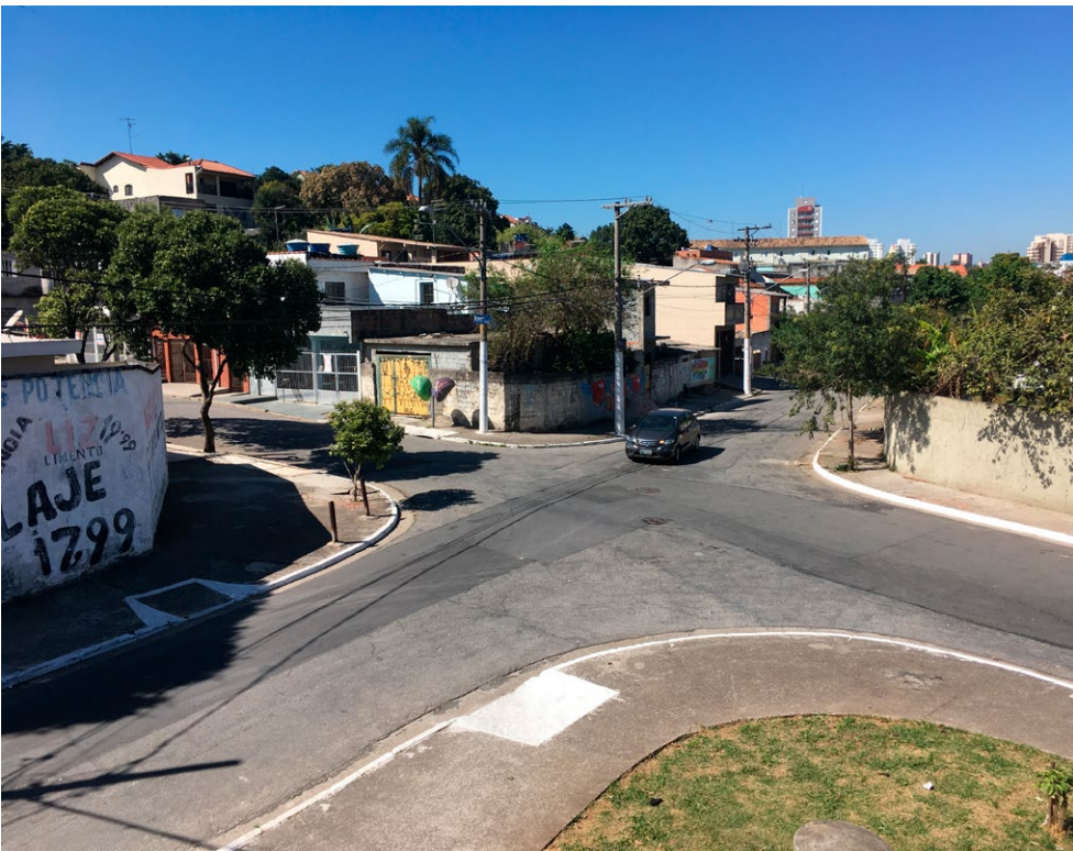
Remodelagem de interseção próxima à passarela de acesso ao CEU, do lado Leste da Av. Jacu-Pêssego, para permitir redução de velocidade dos veículos que saem da via expressa em direção aos bairros. Foto: Autores
