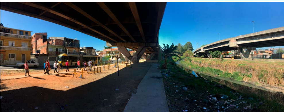
Parque localizado abaixo do viaduto da Av. do Imperador, com acúmulo de lixo. Foto: Autores
