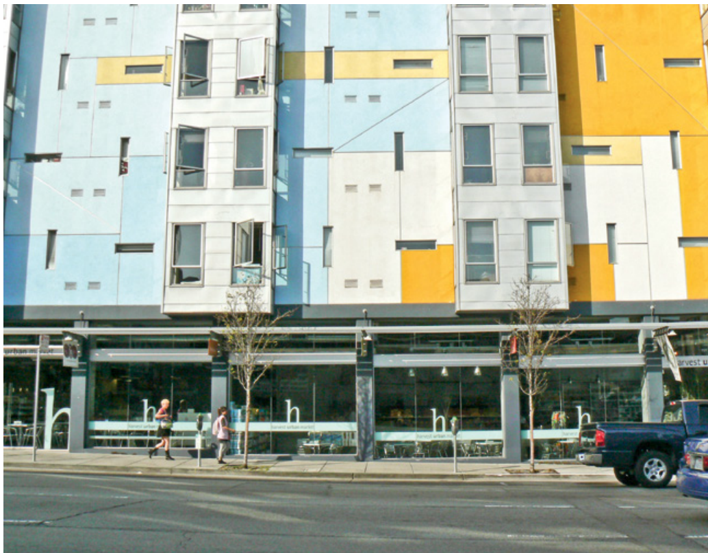
Este projeto implantado no bairro Soma de San Francisco, Califórnia, EUA, inclui habitação popular e usos comerciais com fachada ativa.
