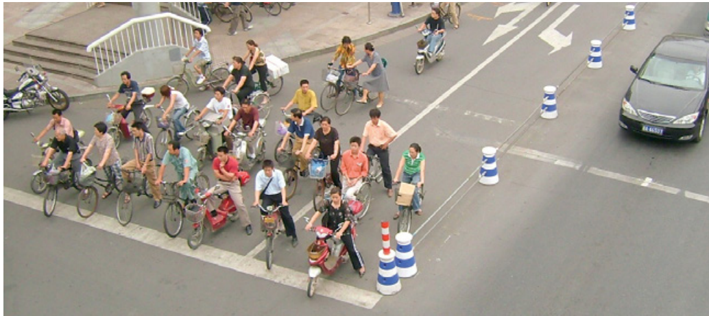
Uma ciclovía de alta capacidade conta com proteção física, faixas de conversão e uma linha de parada avançada para os ciclistas em Hangzhou, China.
