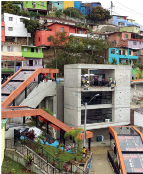
Em Medellín, Colômbia, as ocupações informais de baixa renda da área Comuna 13 se beneficiaram de melhorias da infraestrutura.
