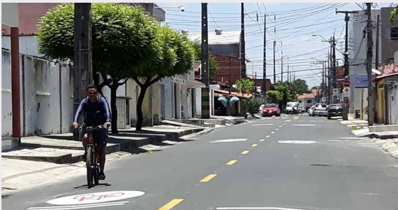
Exemplo de ciclorrota com sinalização horizontal adequada aos critérios estabelecidos pelo CONTRAN, em Fortaleza. Foto: Gustavo Pinheiro
