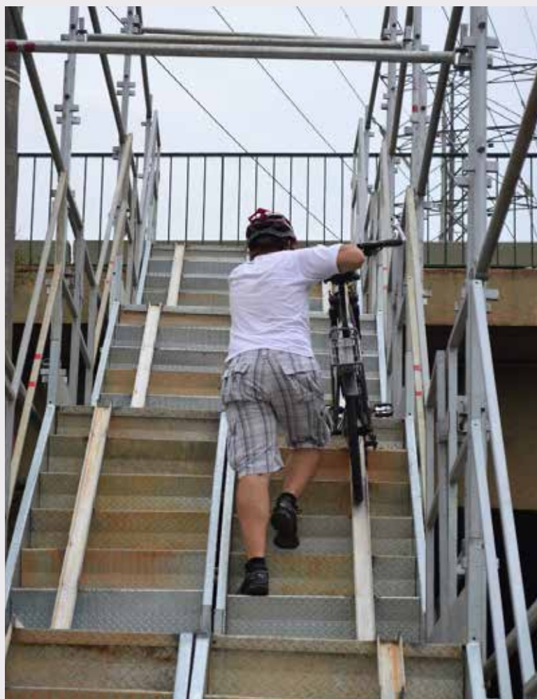
Exemplo de canaleta metálica instalada junto a uma das laterais da escada. Foto: Portal Vá de Bike
