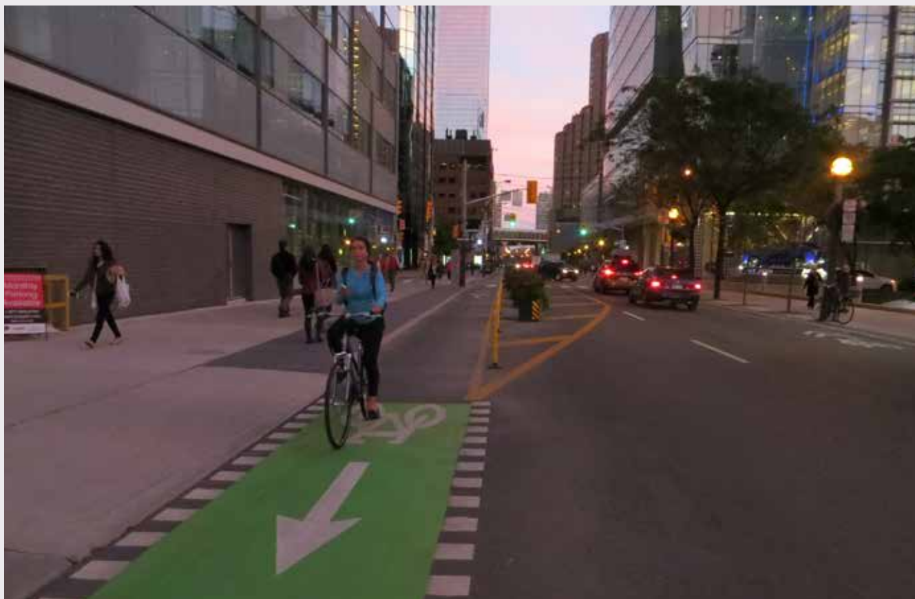
Ciclofaixa no contrafluxo com área de amortecimento ( buffer ) em Toronto, Canadá. O buffer adotado é suficiente para garantir a segurança do ciclista, diminuindo o risco de colisões frontais com o tráfego motorizado. Por outro lado, utilizou-se mobiliário urbano como floreiras para qualificar o espaço de circulação nesta área de amortecimento. Foto: Danielle Hoppe, ITDP Brasil
