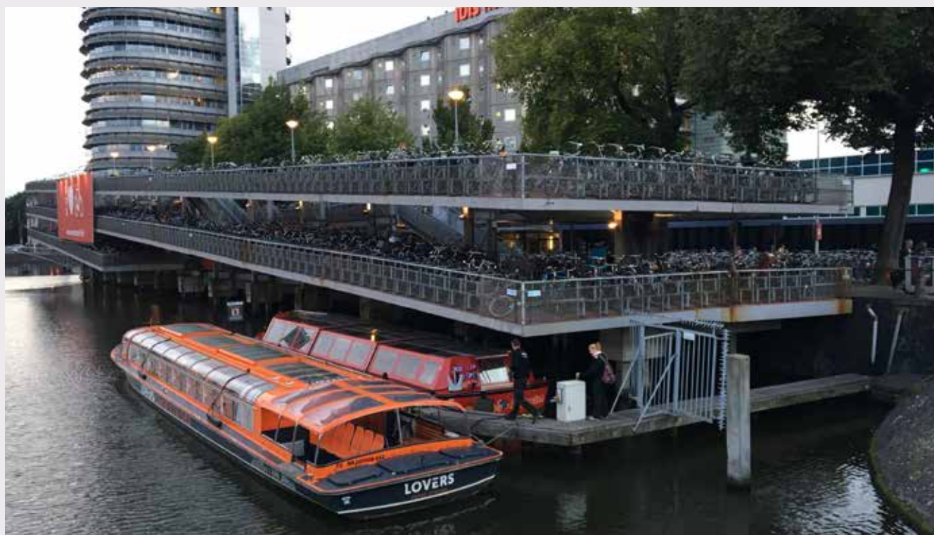
Exemplo de infraestrutura cicloviária que leva ao estacionamento de bicicletas em uma estação de transporte de alta capacidade na cidade de Groningen, na Holanda. Os ciclistas não precisam desmontar da bicicleta antes de chegar onde estacionarão, nem vencer barreiras físicas com as bicicletas ou outros mobiliários de apoio para o acesso ao estacionamento. Contudo, ele não é completamente protegido de intempéries e não conta com controle de acesso ou vigilância. Amsterdã, Holanda. Foto: Thiago Benicchio, ITDP Brasil
