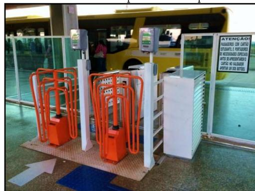
Na ausência de equipamentos adequados, foram instaladas catracas convencionais de ônibus para o controle de acesso de passageiros.
