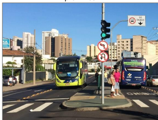
Nas interseções em que o corredor passa, é proibido conversões do tráfego comum à esquerda.
