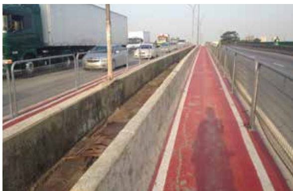
Ciclovía em local isolado Ponte dos Remédios, Zona Norte
