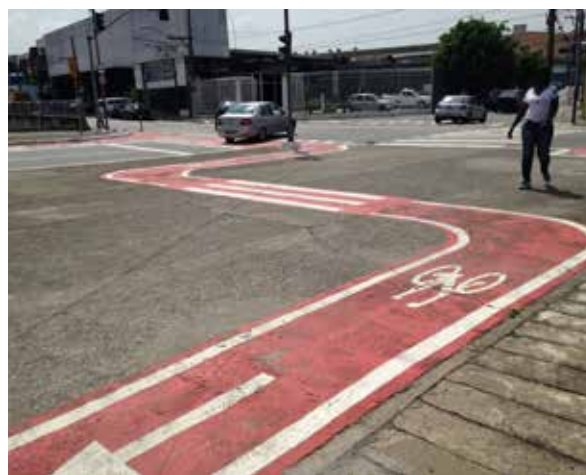
Falta de vinculação com linha de desejo diagonal Av. Eng. Caetano Álvares, Zona Norte
