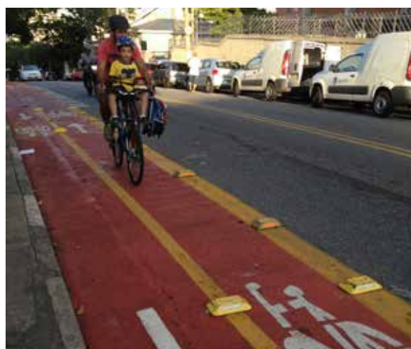
Ciclofaixa bidirecional com largura inadequada R. Jaguaré, Zona Oeste
