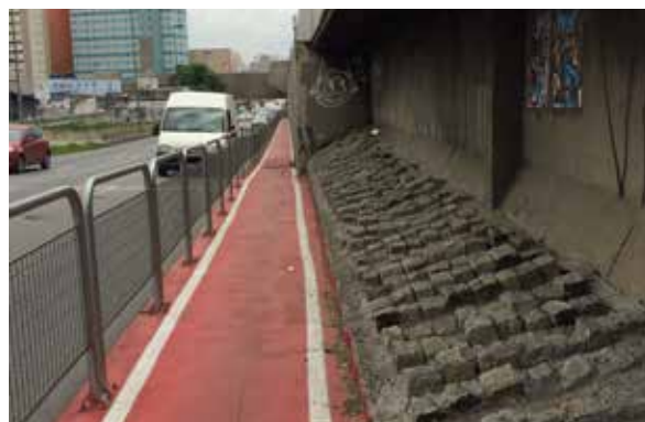
Ciclovía em local isolado e sem iluminação adequada Ponte Cruzeiro do Sul, Zona Norte
