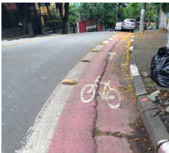
Ciclofaixa unidirecional tomada por irregularidade da sarjeta R. Ásia, Zona Oeste
