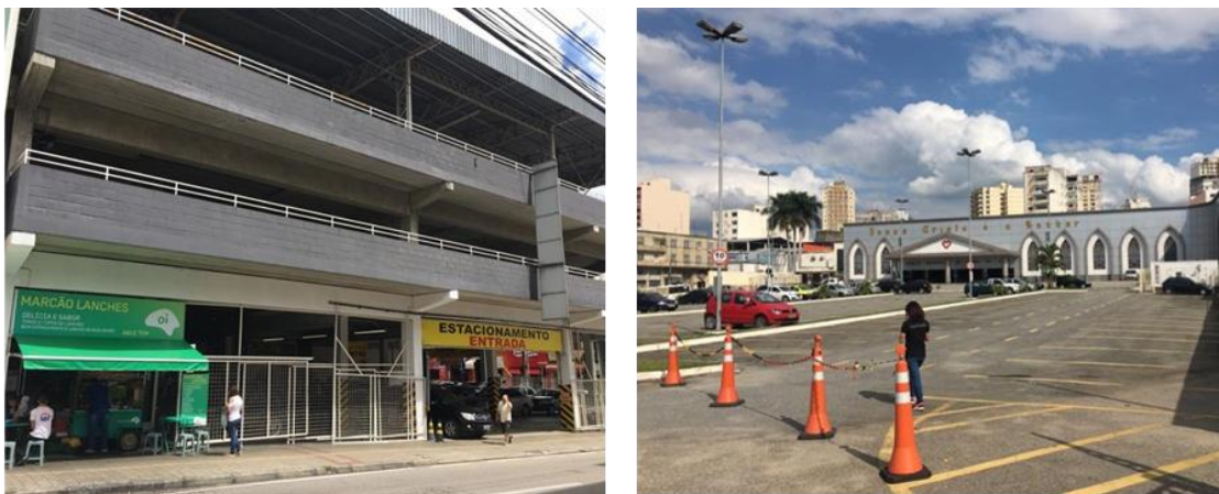
Figura 12: Edifício e áreas de estacionamento em Sorocaba
