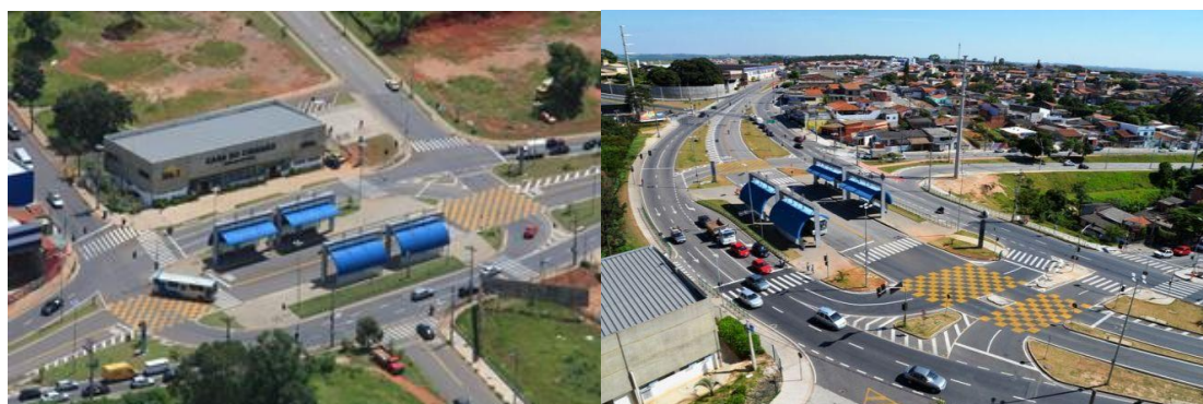
Figura 6. “Áreas de Transferência” em Sorocaba. Cabe ressaltar que ao lado destas infraestruturas, em geral está localizada a “Casa do Cidadão”, local da onde se reúnem serviços públicos, o que pode evitar a ida ao centro da cidade pela população.
